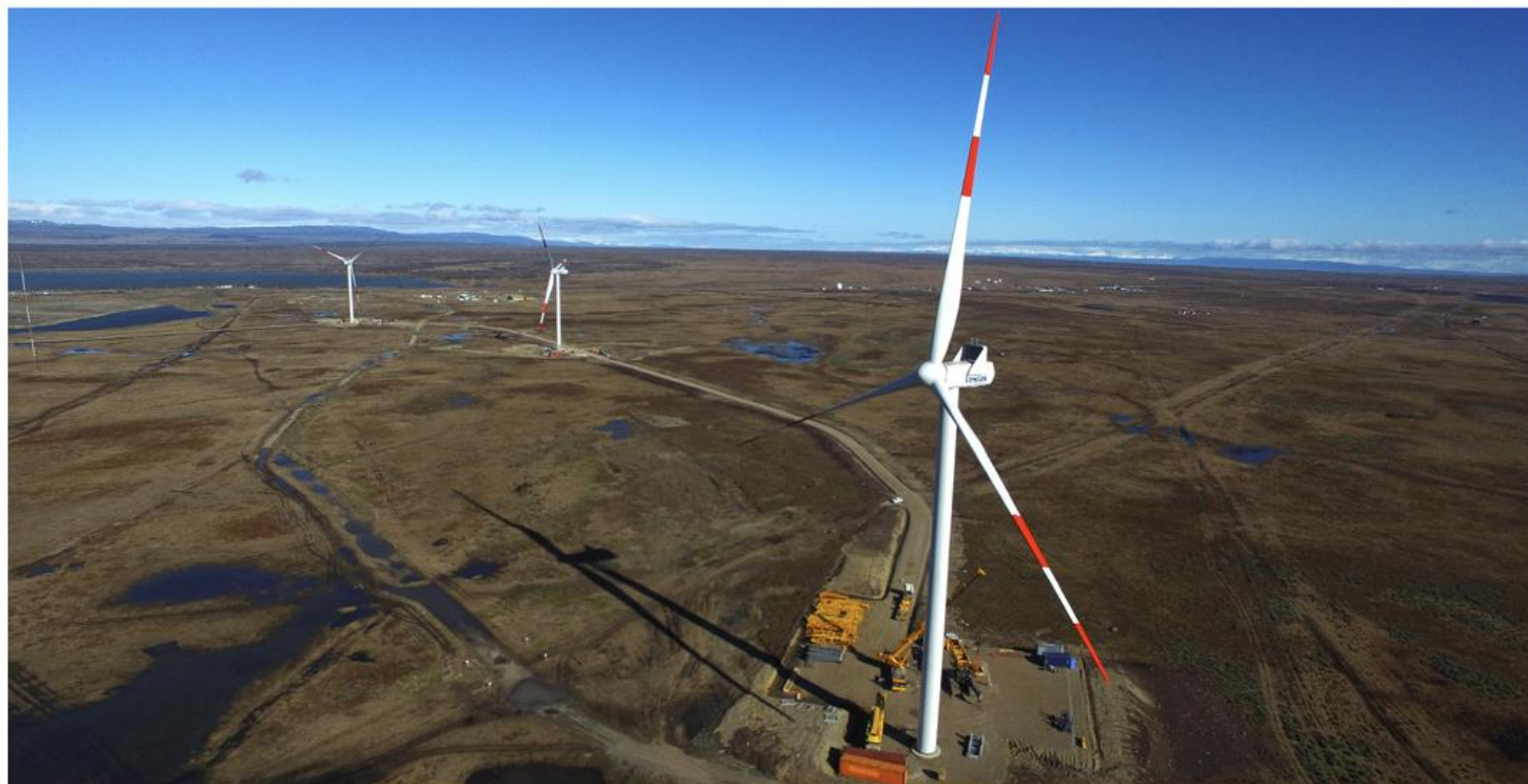
Wind park Vientos Patagónicos: Power 10,35 MW
